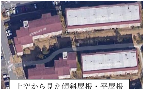
上空から見た傾斜屋根・平屋根
